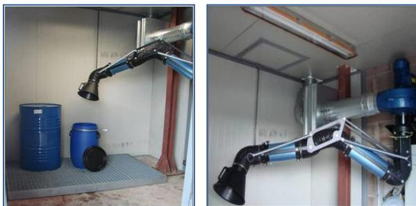
Figura 10: aspirazione SOV per mezzo di braccio meccanico collegato a filtro a carboni attivi
