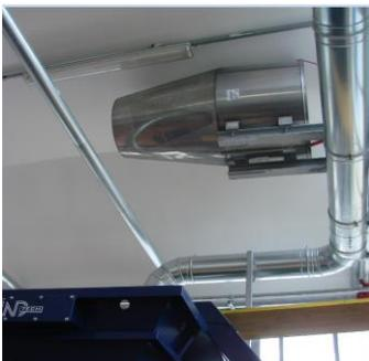
Figura 11: impianto di aspirazione nell'area di triturazione
