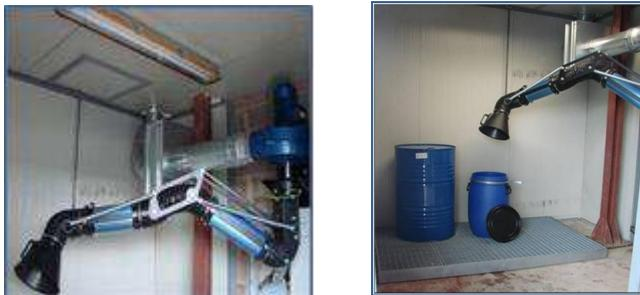
Figura 9: aspirazione SOV per mezzo di braccio meccanico collegato a filtro a carboni attivi
