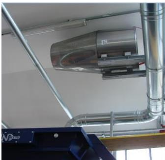
Figura 10: impianto di aspirazione nell'area di triturazione
